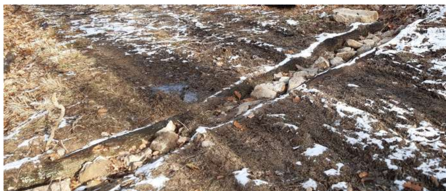
Realizzazione di canalette in pietra e legno. Gradini e sistemazioni sponde laterali in legno.
