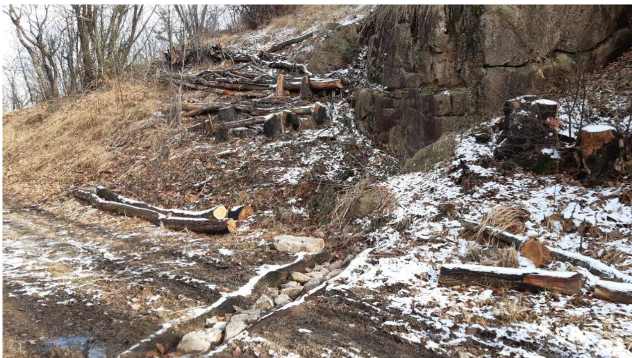
Sentiero 4, metà percorso, interventi di abbattimento, realizzazione di cataste con funzione anti erosiva e costruzione di conalette in legno e pietra.
