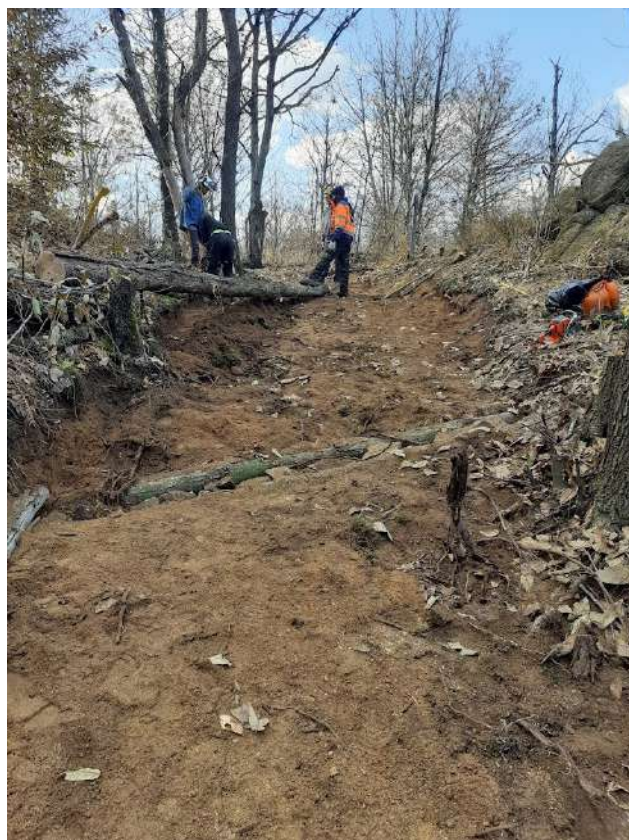
Realizzazione di canalette in pietra e legno. Gradini e sistemazioni sponde laterali in legno.
