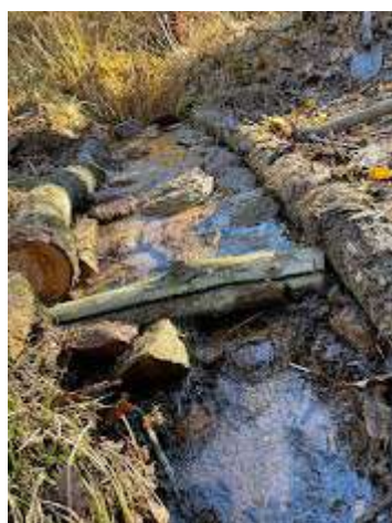
Realizzazione di canalette in pietra e legno. Gradini e sistemazioni sponde laterali in legno.
